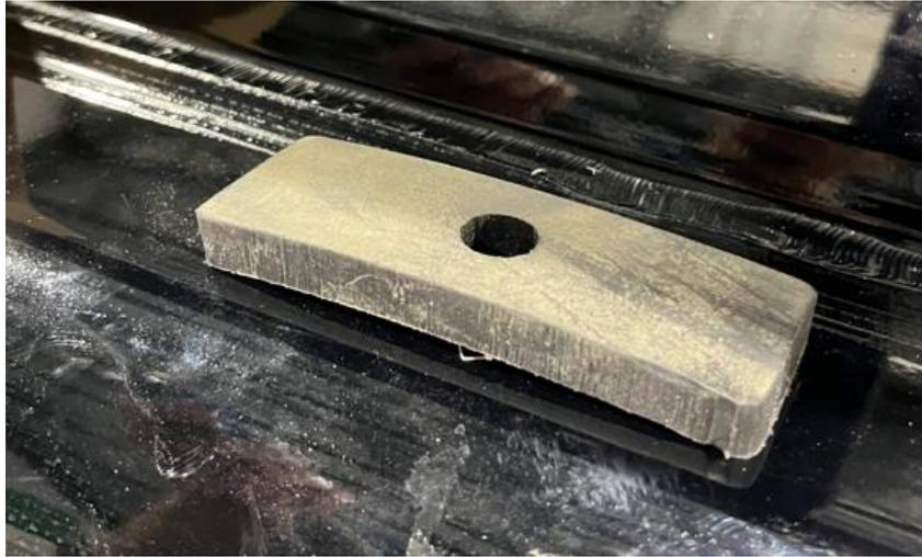
4.7 Appliquer un 2<sup>e</sup> généreux joint de scellant sur les 6 caoutchoucs autour du trou de ce dernier.
