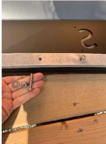
5.1.3. Insérer les rondelles d'espacement  $\frac{1}{4}$ " et les écrous de nylon  $\frac{1}{4}$ "-20.
