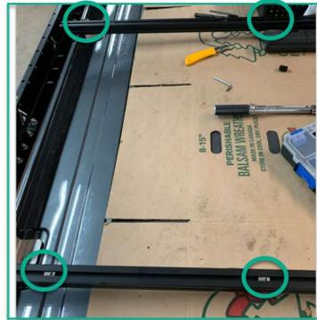
1.2. Positionner les "springs nuts" à la même distance que les trous d'assemblages de votre panneau solaire à installer.
