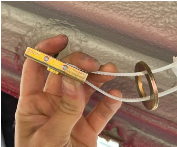
3.1 Insérer la tête de l'ancrage dans le trou
