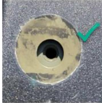
1.4.2 Au besoin, couper la tôle du toit avec des ciseaux à métal afin de dégager l'alésage. Il faut peindre la tôle découpée avec de la peinture à métal.
